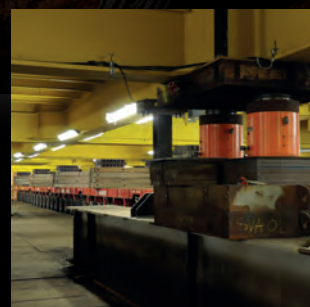
Cylindry do podnoszenia ładunków o ciężarze 590 ton
